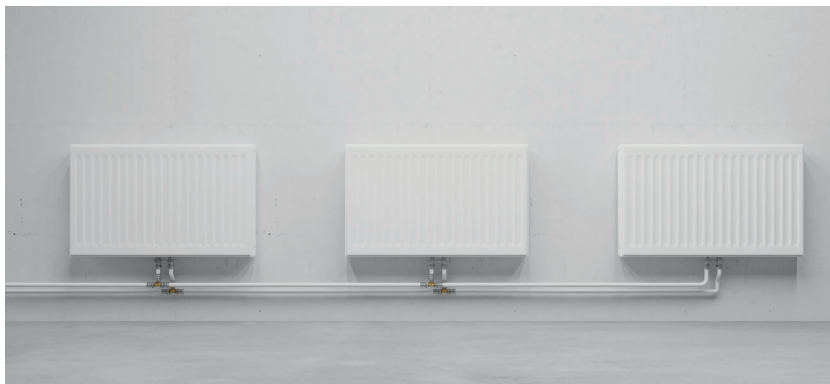
Joon. 47. Kahe toruga radiaatorküte.
