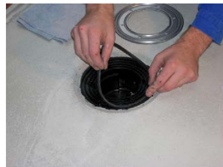
3. Eemaldage kate, puhastage äärik ja sisestage tihend.
