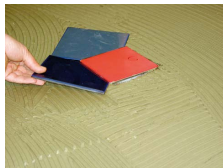
12. Sisestage pikendus ilma tihendita. Paigaldage plaadid.
