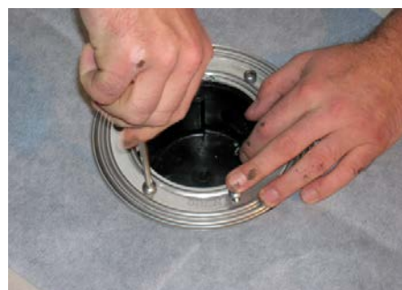
5. Kinnitage roostevabast terasest rõngas kruvidega.
