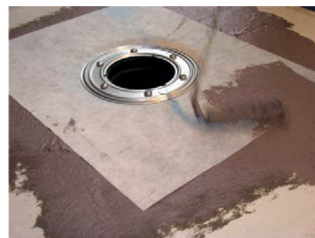
9. Kandke vedel hüdroisolatsioon kogu märjale pinnale.
