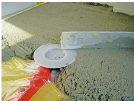
1. Tasandage betoonikiht ja mõõtke trapi katte kõrgus.
