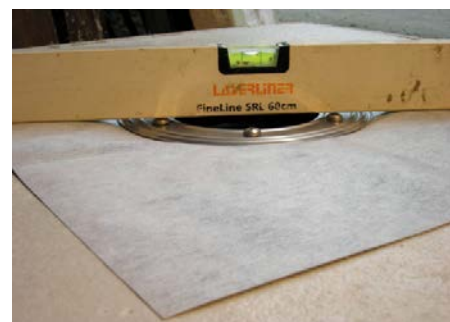
6. Tihenduskomplekt peab jääma betooni alla.
