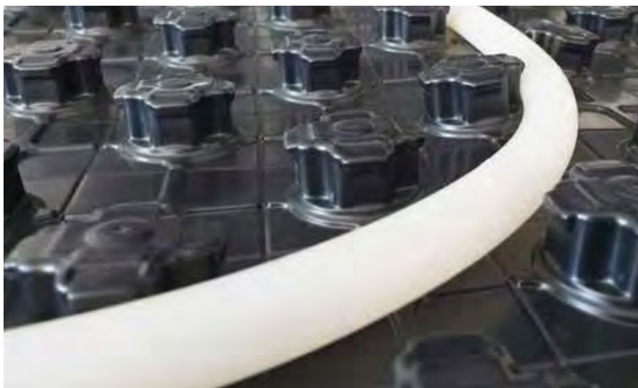
Mocowanie rury ogrzewania podłogowego w macie Eurotop Fastening underfloor heating pipe in Eurotop castellated mat
