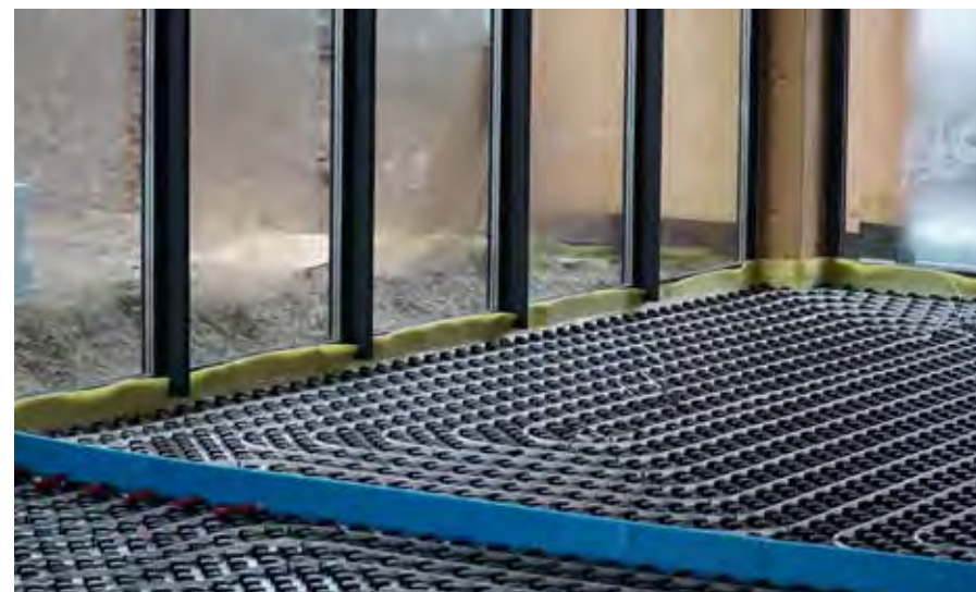
Instalacja ogrzewania podłogowego z wykorzystaniem maty Eurotop Underfloor heating installation with usage of Eurotop castellated mat
