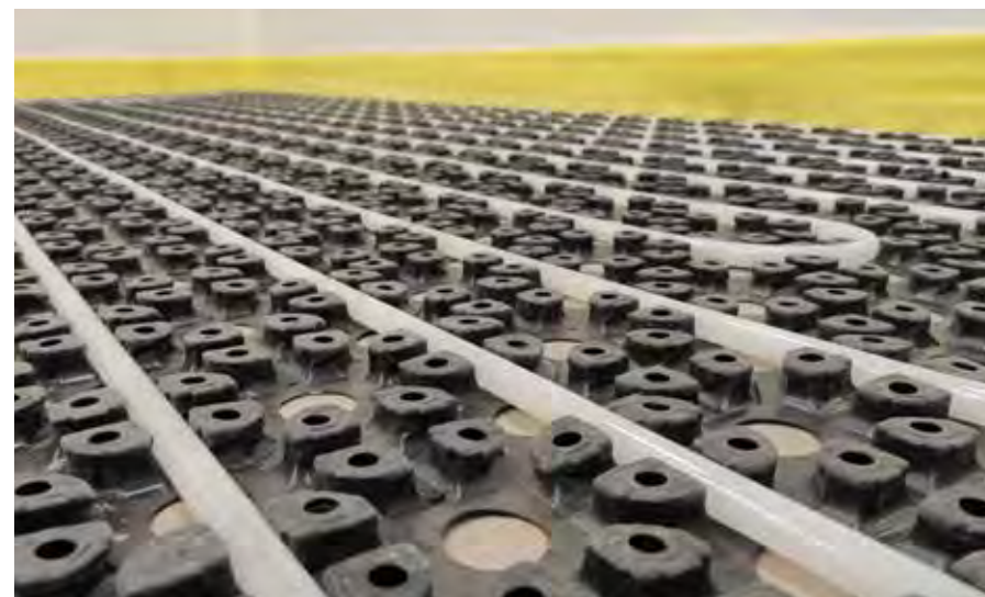
Mocowanie rury ogrzewania podłogowego w maty Eurorenova Fastening underfloor heating pipe in Eurorenova castellated mat
