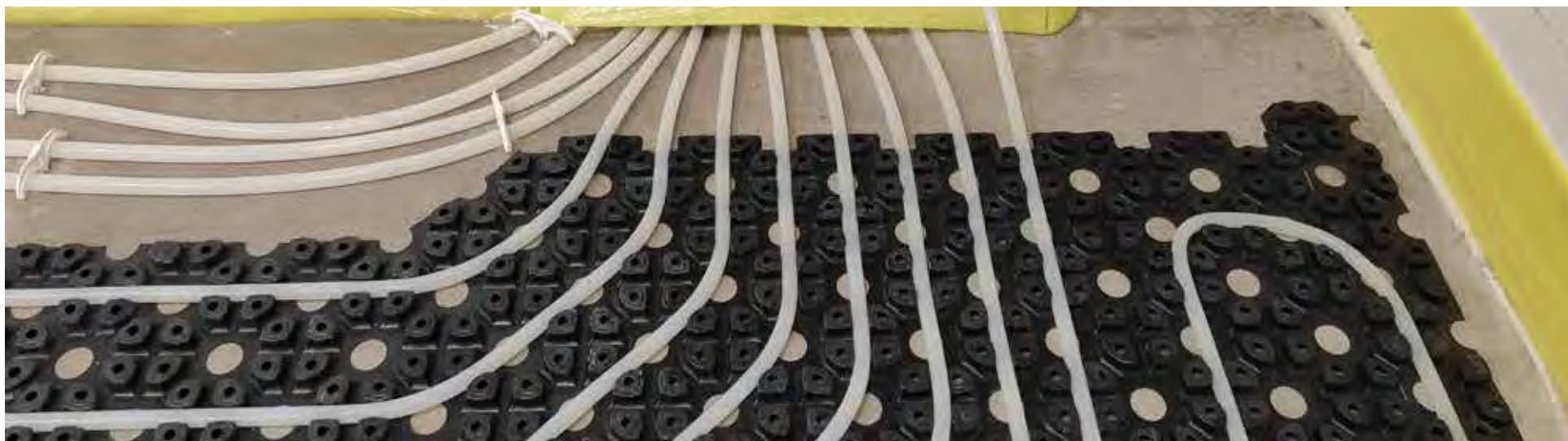
Doprowadzenie rur do skrzynki rozdzielczej Provision of pipes to manifold cabinet
