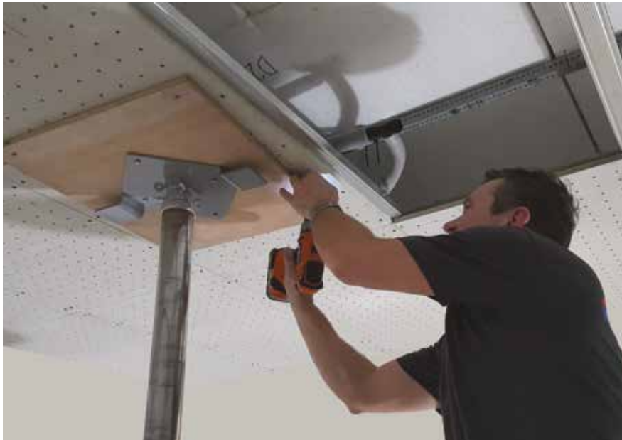
Montaż paneli sufitowych Assembly heating - cooling panels
