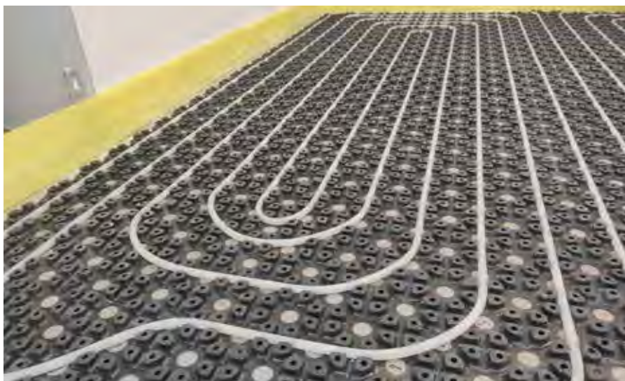
Instalacja ogrzewania podłogowego z wykorzystaniem maty Eurorenova Underfloor heating installation with usage of Eurorenova castellated mat
