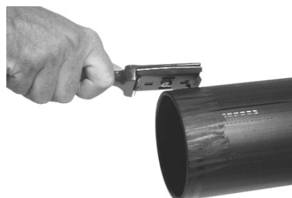
Joonis 55. Kraapida toruotsi käsikaabitsaga
