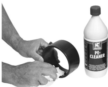
Joonis 57. Puhastada muhvi sisepinnad PE-puhastusainega
