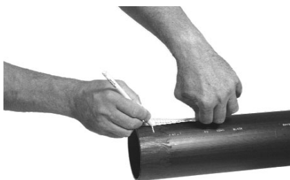
Joonis 56. Märkida sisselükkamisulatus
