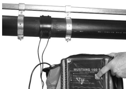
Joonis 59. Õige kinnitamine enne keevitamist
