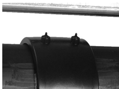
Joonis 60. Kontrollida sisselükkamisulatust ja keevitusmärgiseid
