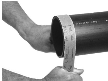
Joonis 53. Hõõruda toruotsi smirgelriidega, mille pinnakareduse klass on 40 või väiksem
