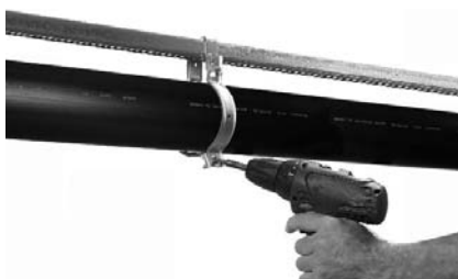
Joonis 80 Keerata ülemine kruvi kinni.
