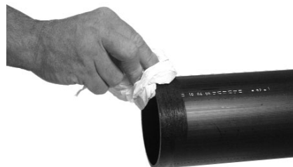
Joonis 53. Hõõruda toruotsi smirgelriidega, mille pinnakareduse klass on 40 või väiksem
